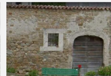
Figura 22 - Fg. 94 part. 142, Particolare dell'imbotto in pietra e del portone d'ingresso
