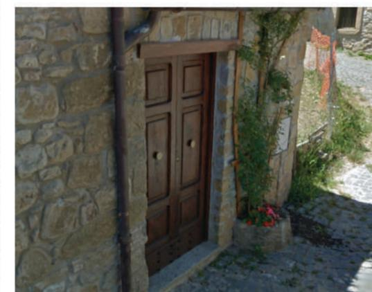
E Apertura con sistema a trillite, con segni di restauro e posizionamento di architrave ligneo
