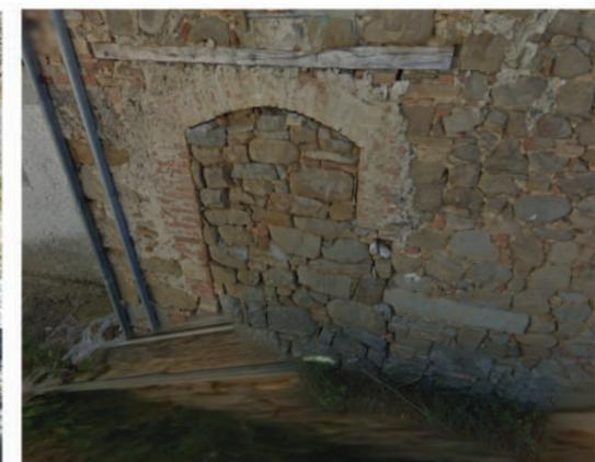
F Tamponatura di antica apertura ad arco, effettuata in prosecuzione ad un tratto di muratura
