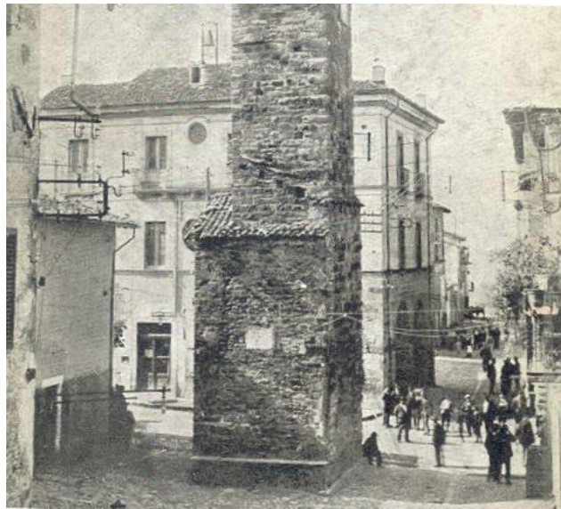
Figura 9 Torre di Amatrice, architettura civica dal grande valore simbolico e pratico costruita non a caso nel punto di incrocio tra Corso Umberto I e Via Roma.
