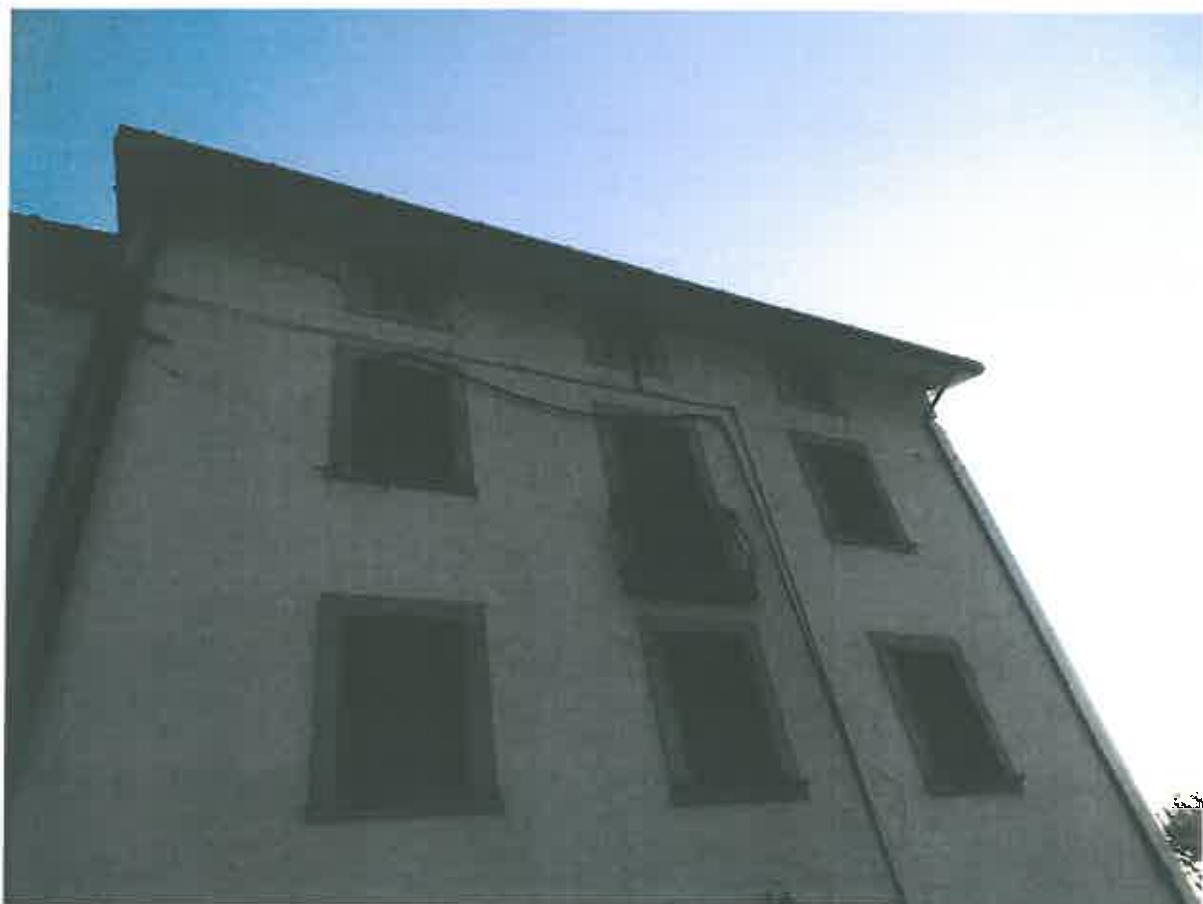
Fabbricato di cui alla p.lla n° 738 (veduta generale a nord su strada SS577)
