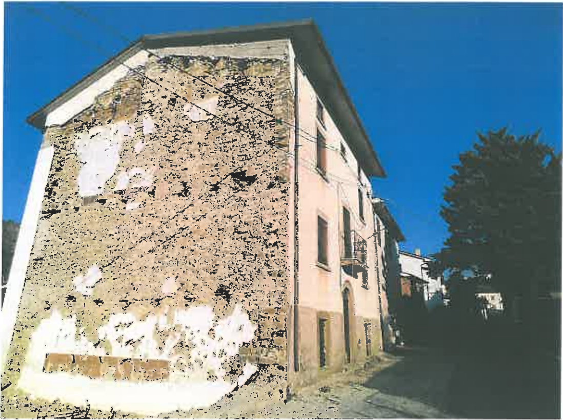
Fabbricato di cui alla p.lla n° 738 (veduta generale ovest, su p.lla 737)
