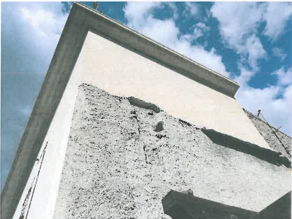
Fabbricato di cui alla p.lla n° 53 (prospetto sud)
