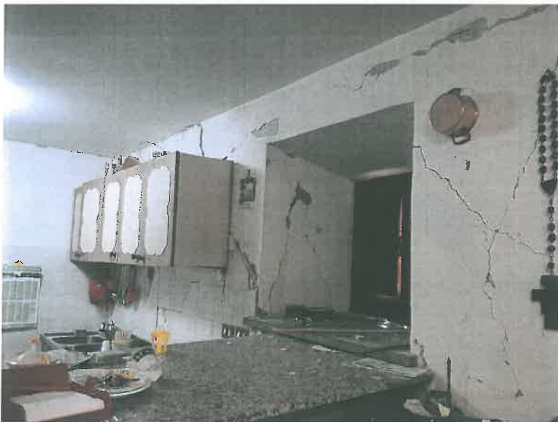
Fabbricato di cui alla p.lla n° 53 lato dx (piano terra)
