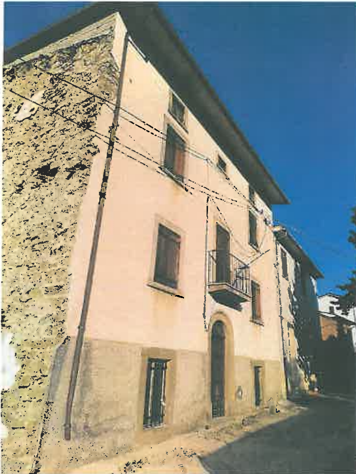
Fabbricato di cui alla p.Illa n° 738 (veduta generale sud, su via interna comunale)
