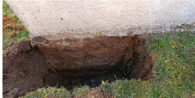
Fig. 1 Report Fotografico saggio in fondazione
