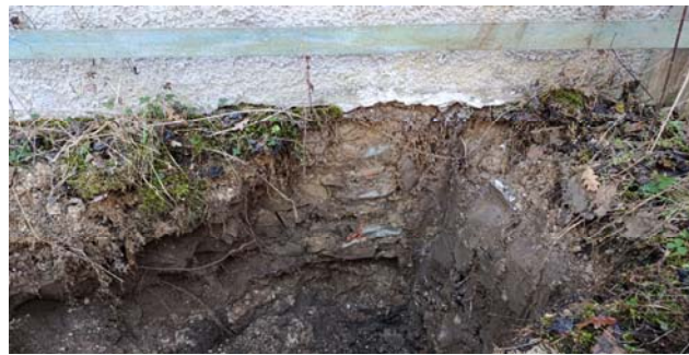
Fig. 1 Report Fotografico saggio in fondazione
